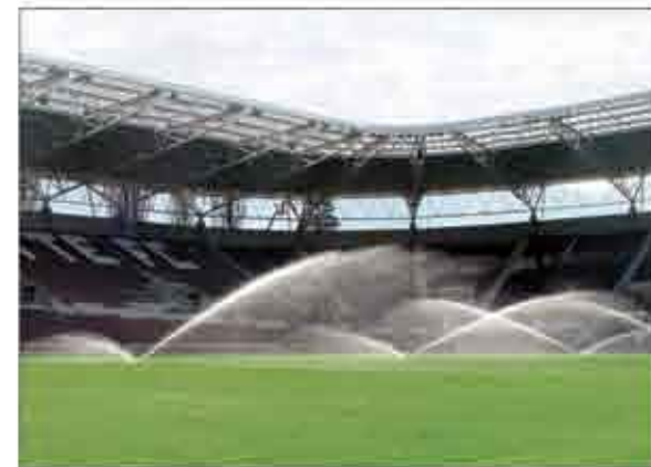
Le turbine I-41-ON di Hunter in funzione nello stadio di Ginevra.
